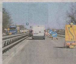
Cantiere in E45
